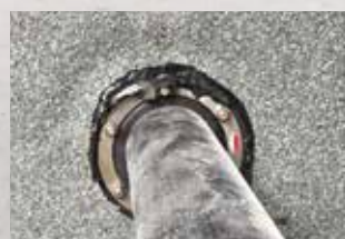
KRASO® Folienklemmflansch Typ FKF - in der Kernbohrung -
