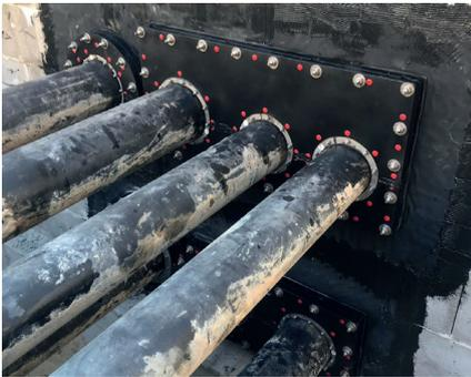
**KRASO® Kunststoffflanschplatte Typ KFP mehrfach mit Folienflansch - Sonder**
