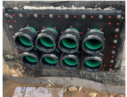
**KRASO® Kunststoffflanschplatte Typ KFP 150 Mehrfach 2x4**
